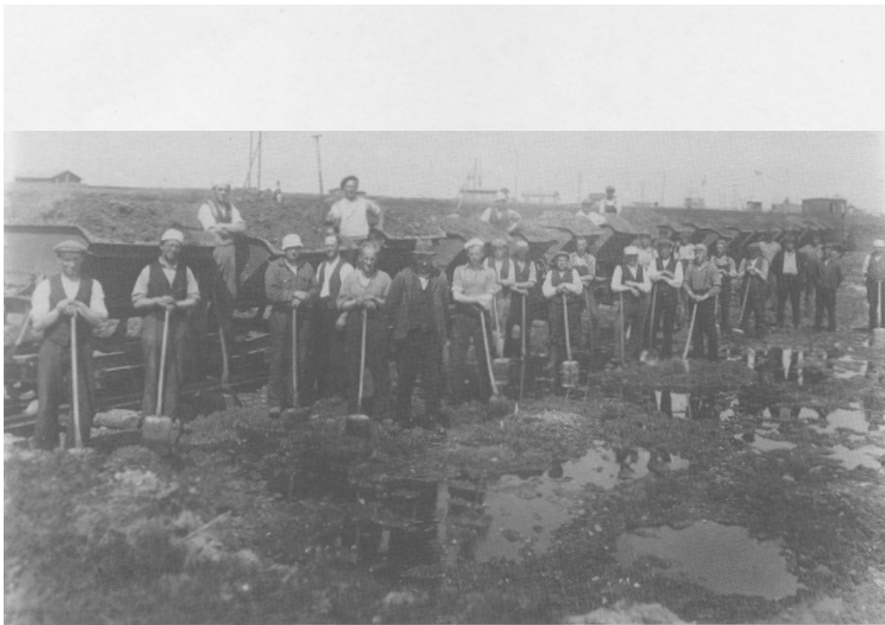
Arbejdere i færd med at læsse fyld til selve opkørslen til broen. Billedet er taget i Oddesund Syd, og foruden arbejderne med skovle ses fra højre arbejdsformanden (med jakke og hat) desuden lokomotivfører, portør samt kantinebestyrer.
