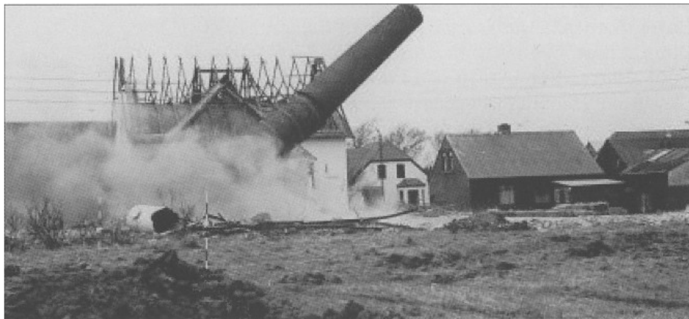
Sprængning af skorstenen på Uglev Andelsmejeri.
